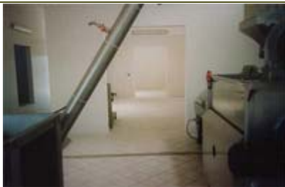
Parte dei locali del frantoio: in primo piano la sala delle macchine, a seguire quella del deposito olio e in fondo quella dell'immagazzinamento delle merci.
